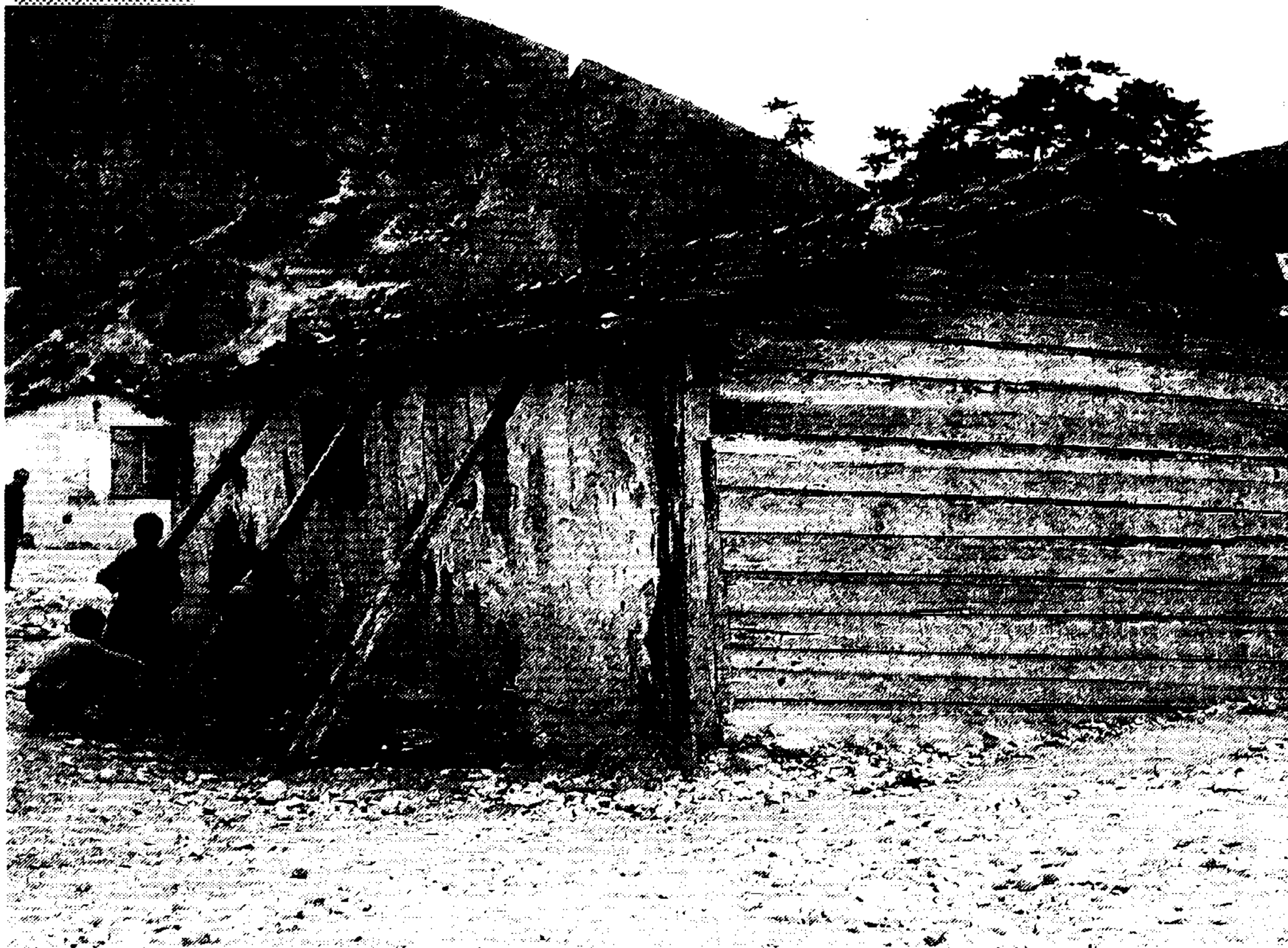
Una baracca di via Nuova a Trasacco puntellata con le travi (archivio Salvi)
