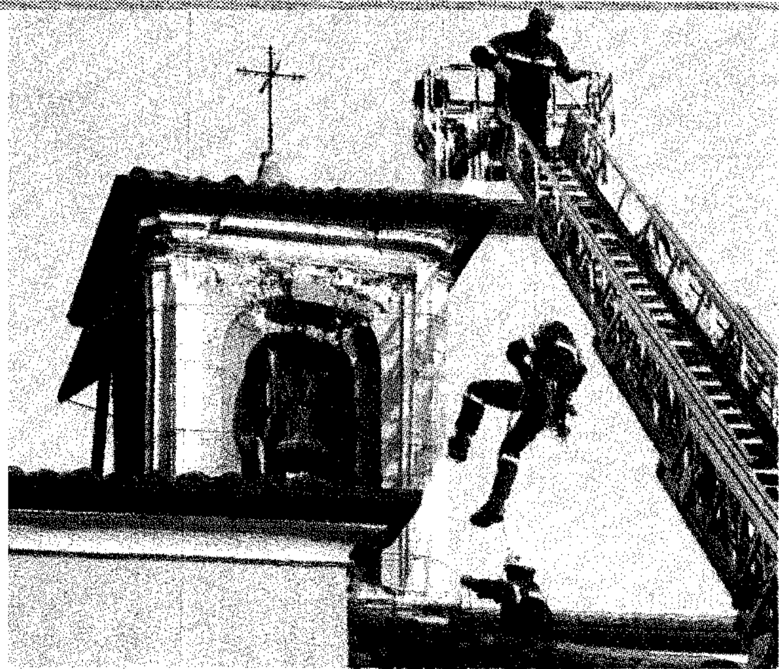
Uno degli edifici di Salò colpiti dal sisma dello scorso novembre (CdG)
